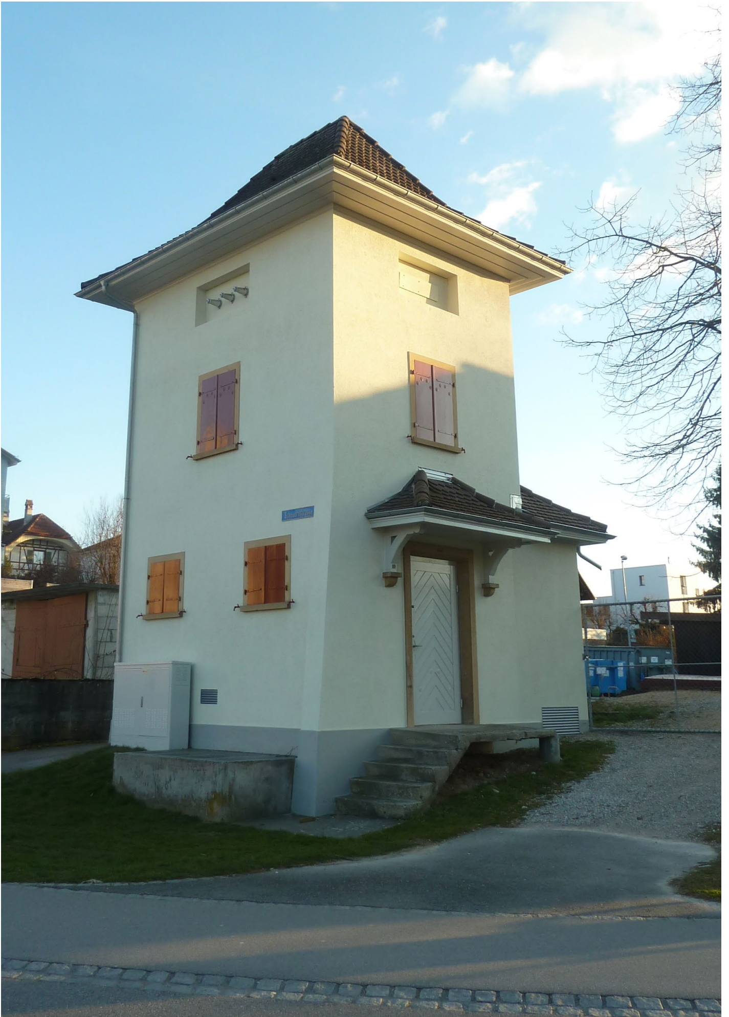
Frisch sanierte Trafostation Sagi, Murten.
