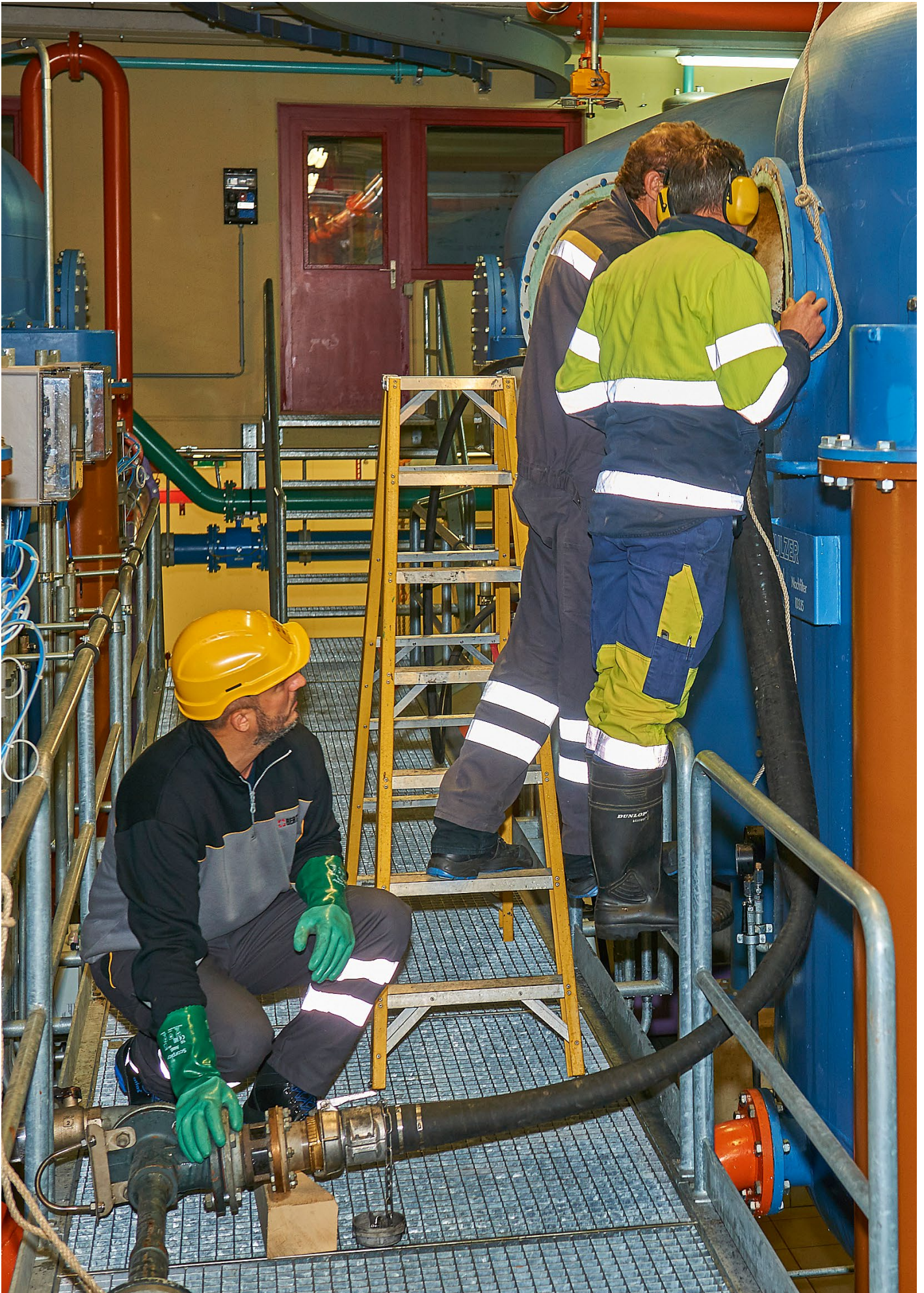
Volle Konzentration beim Austausch der Aktivkohle in der Filteranlage des Seewasserwerks.
