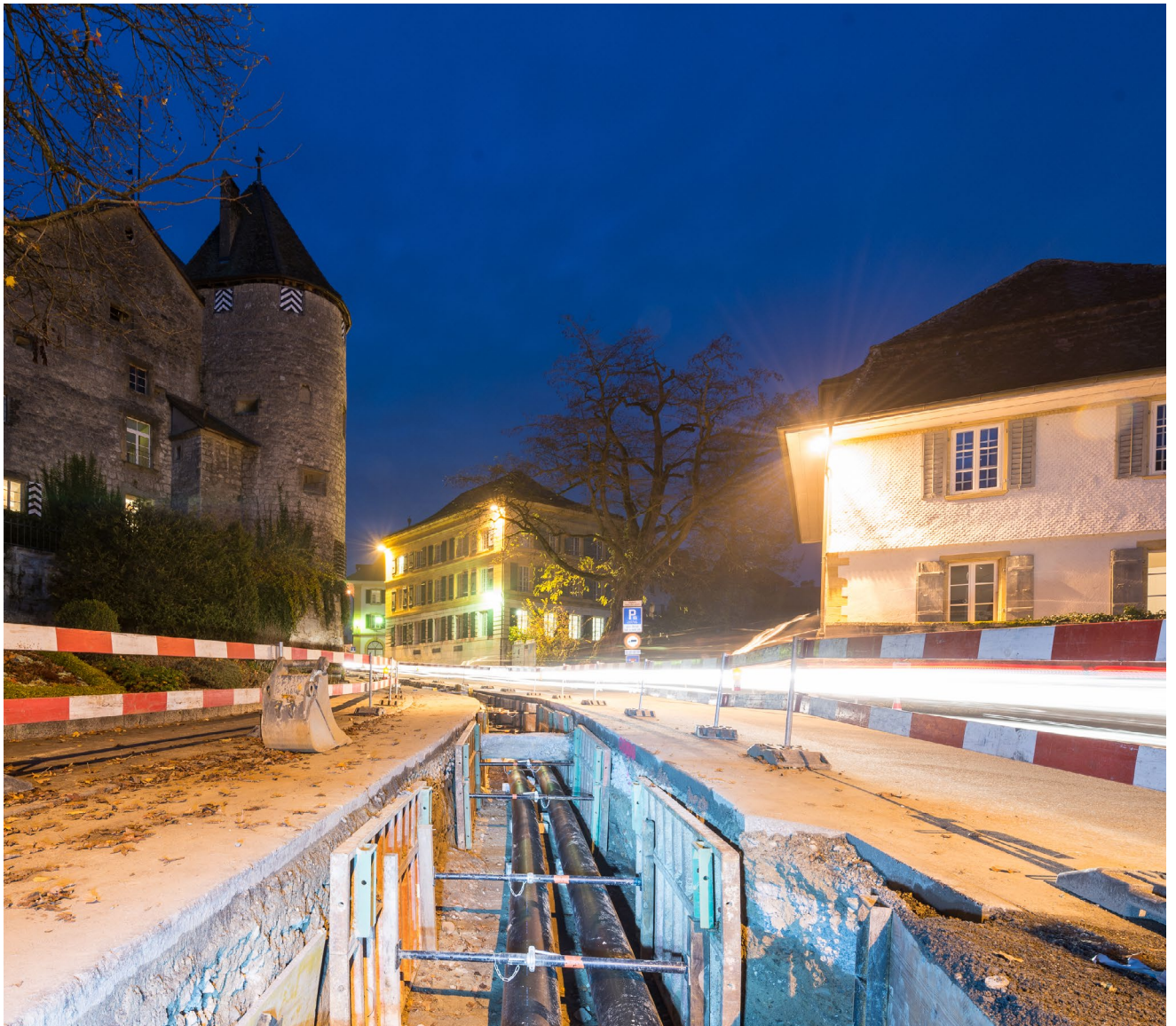
Fernwärme-Leitungsbau an der Lausannestrasse aus dem Jahr 2016.
