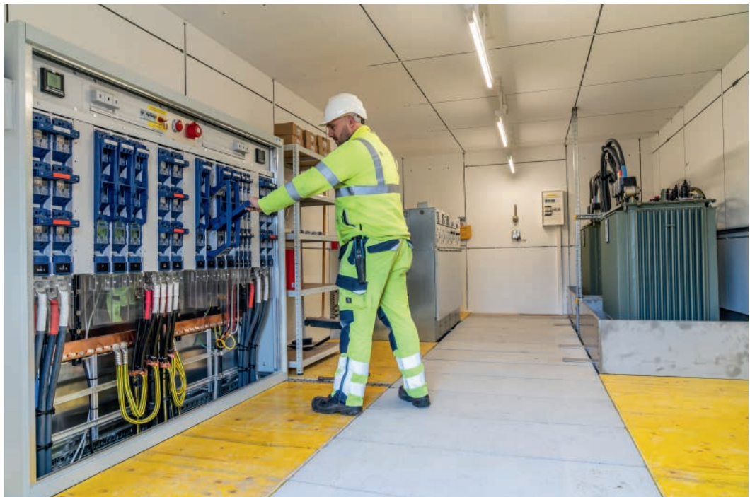
Arbeiten in der frisch sanierten Trafostation SBB Centre Löwenberg.
